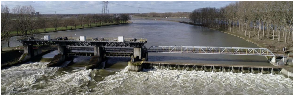
Figuur 2-5 Stuw Linne met links Stoney (3 openingen) en rechts Poirée (15 openingen)
